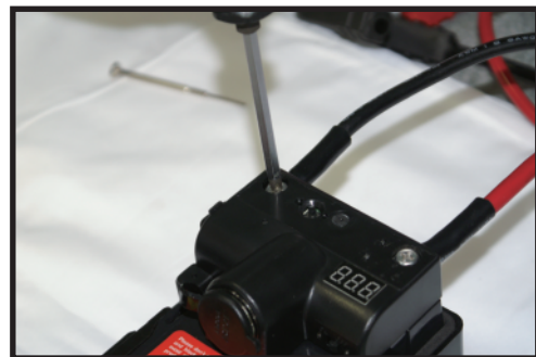
③ プラスドライバーにて、ケーブルの取付ボルトを外します。
